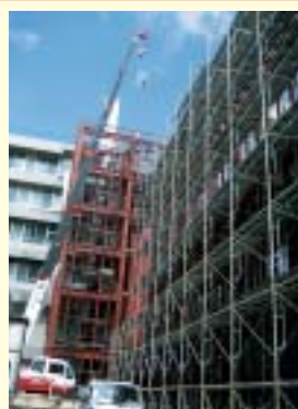
仮設渡廊下(右)とエレベーター
