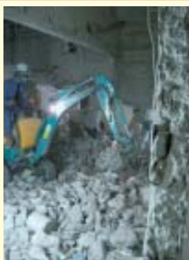
本館地下薬剤部他
