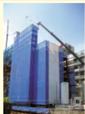
仮設エネルギー棟他
