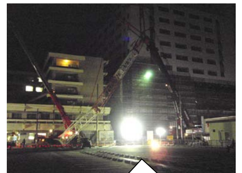
タワークレーン解体の
